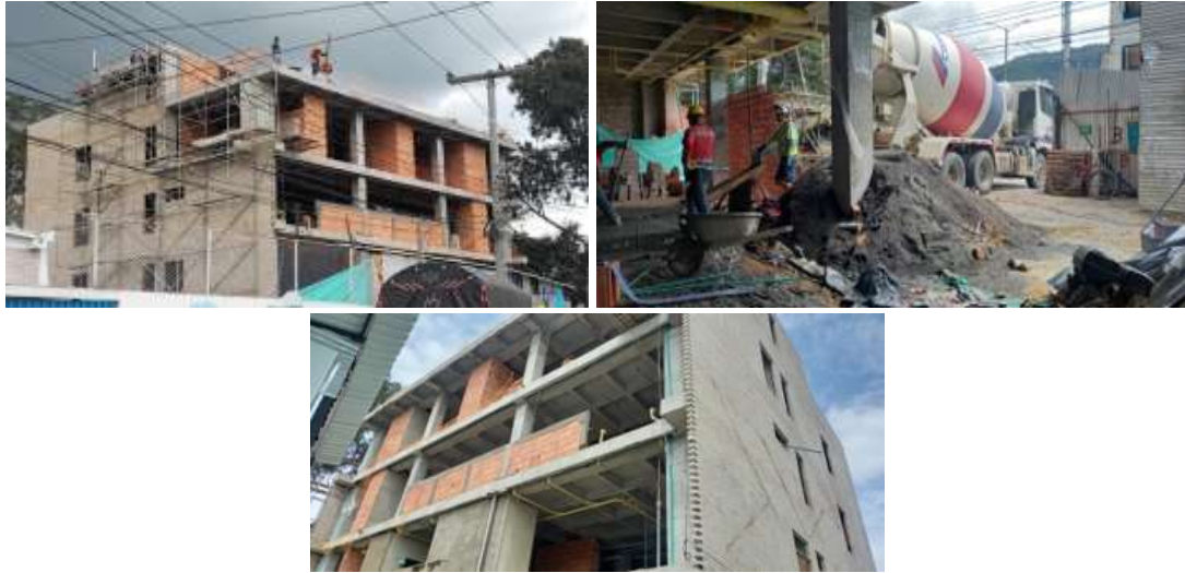
Ilustración 5 IMÁGENES DE AVANCE PROYECTO CAPS. VEBENAL.
