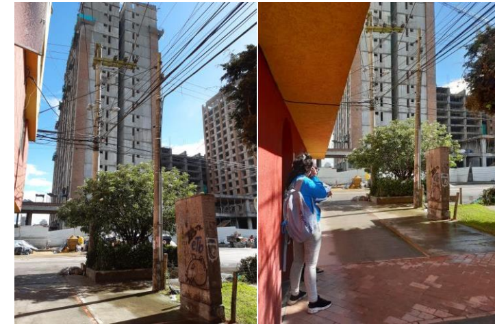
Fuente: Línea aire, ruido y REM, Subred Norte, abril 2021
