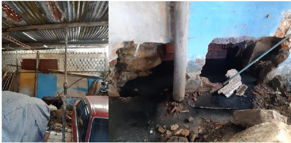
Fuente: Línea de aire, ruido y Rem, Subred Norte, mayo 2021
