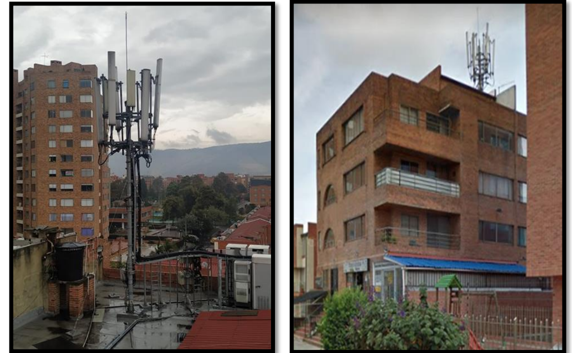
Queja por radiaciones electromagnéticas de antena de telecomunicaciones, Barrio La Victoria Norte, UPZ El Prado, Localidad Suba, septiembre de 2019
